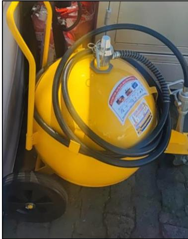
*Imagen 1. Extintor ABC 150 lb recarga, prueba hidrostática y mto preventivo vigente*
