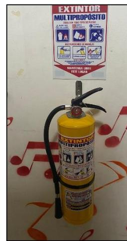
*Imagen 3. Extintor ABC 10 lb recarga, prueba hidrostática y mto preventivo vigente*
