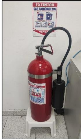
*Imagen 2. Extintor ABC recarga, prueba hidrostática y mto preventivo vigente*
