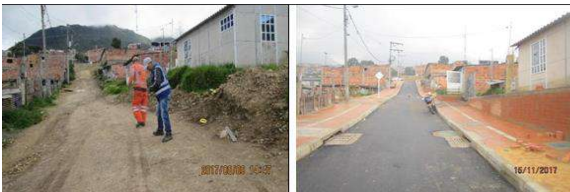
Ilustración No. 9. Construcción malla vial y andenes Barrio La Belleza, Fondo de Desarrollo Local San Cristóbal
