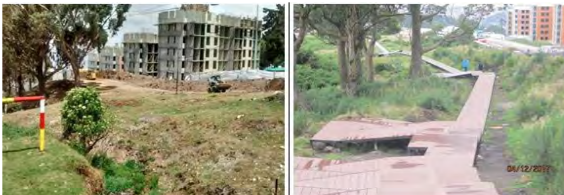
Ilustración No. 10. Construcción sendero Verejones, Fondo de Desarrollo Local San Cristóbal
