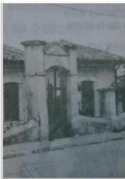
Imagen 13. Casa en abandono, años 70. El portal de entrada estaba con parales y soportes para que no se cayera, no tenía el refuerzo del dintel horizontal actual. Su puerta de madera con forja que en algún momento del tiempo desapareció. Fuente: recorte de periódico local de San Cristóbal, sin más datos.
