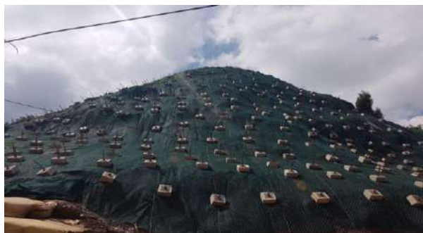
Ilustración No. 8. Obra de mitigación barrio Alpes Futuro, Fondo de Desarrollo Local San Cristóbal
