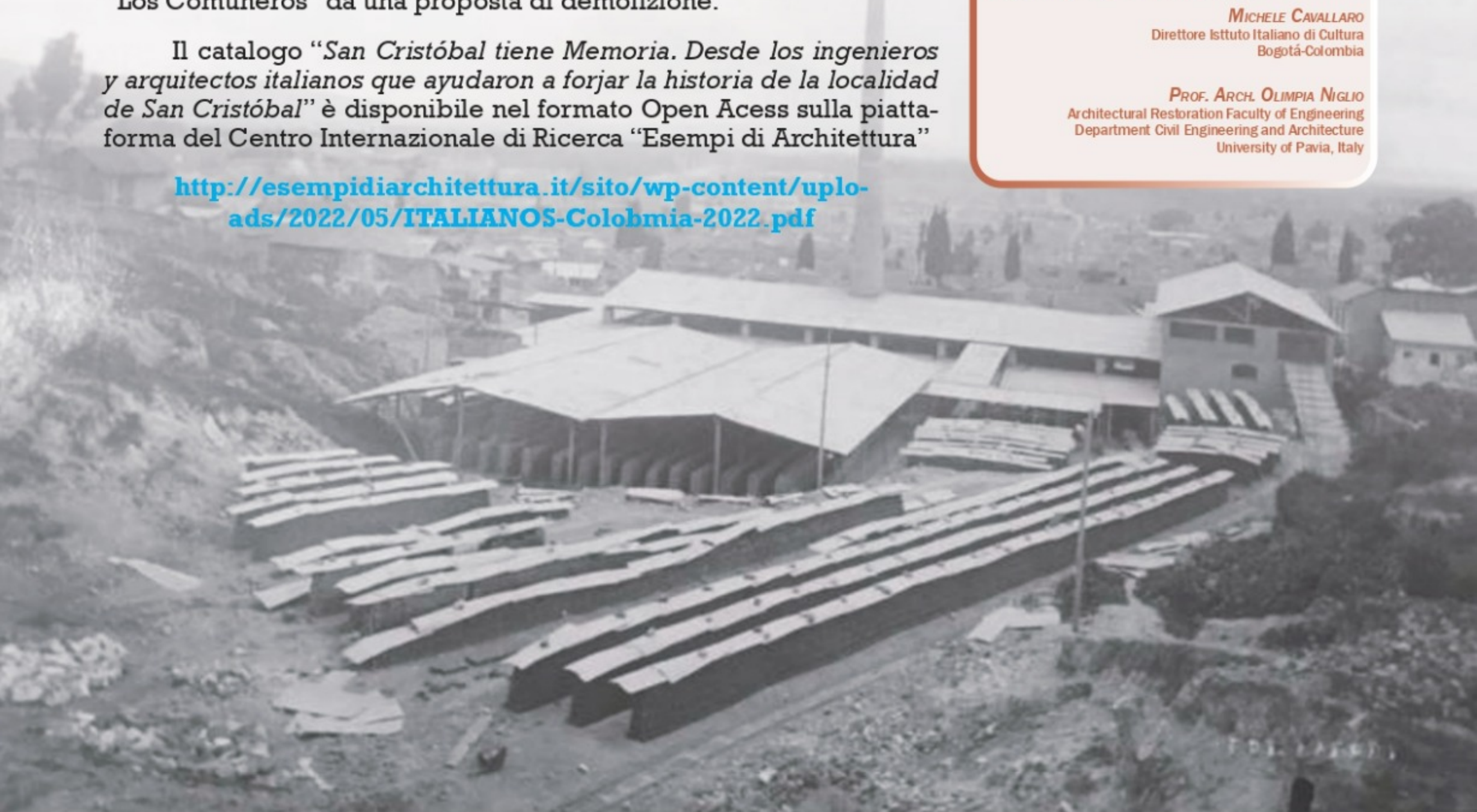
Fábrica de ladrillos -SAIL-, en el sitio donde actualmente es la plaza de mercado del sector del 20 de Julio, 1930 aprox. Fuente: Jorge Di Terlizzi 2018 y RHM. // Obra ya demolida
